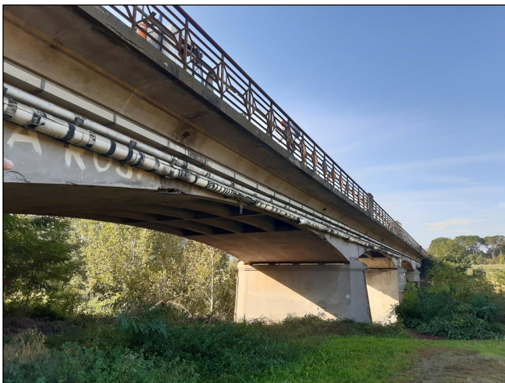
3. Vista laterale dell'impalcato del Ponte della Chiusa
